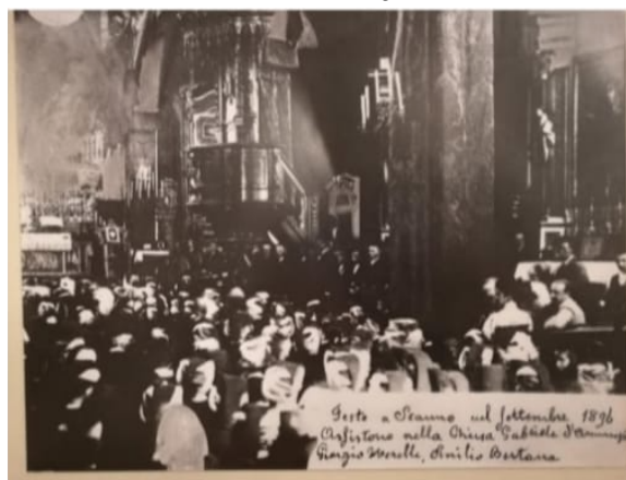
1896, 20 settembre: Foto scattata da Olinto Cipollone.
